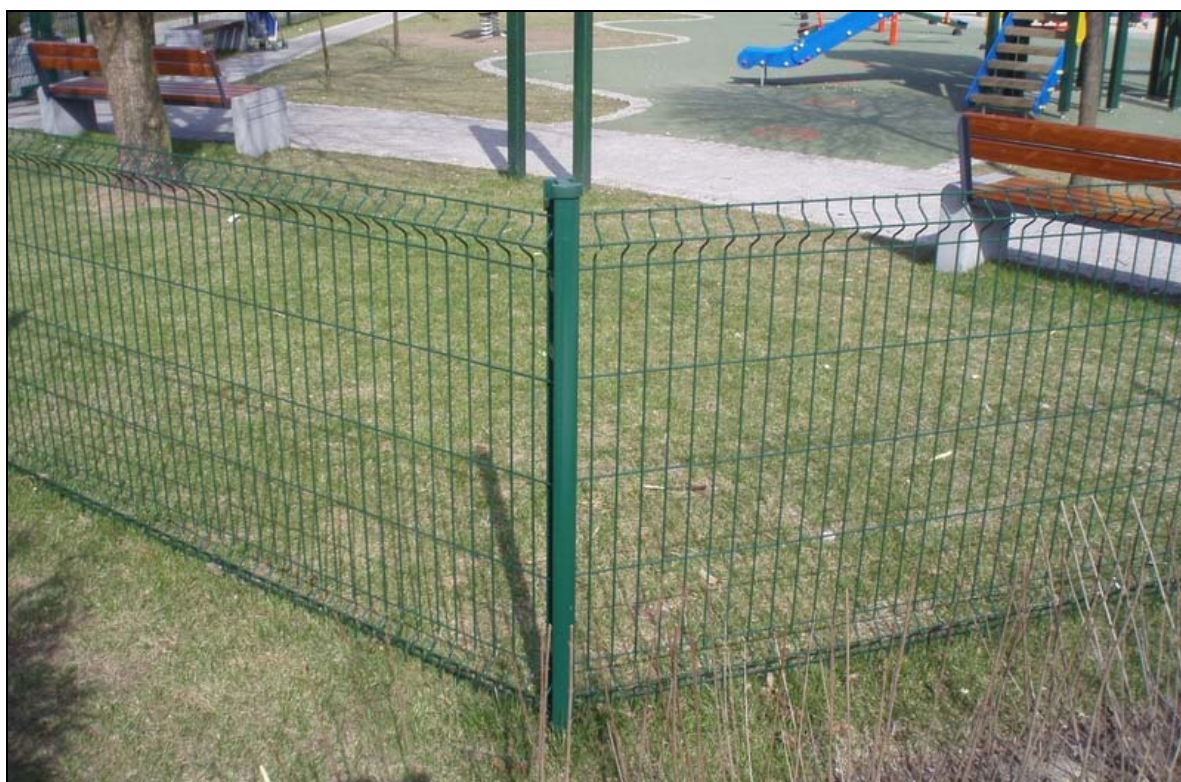
Fot.4 Projektowany typ ogrodzenia panelowego.
